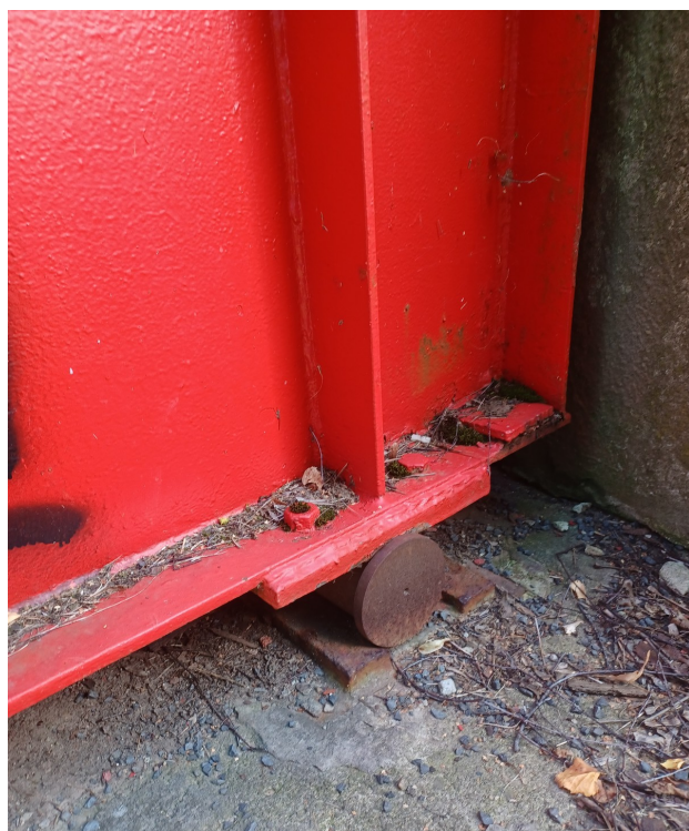
Obrázek 6: Detail podepření NK na opěře
