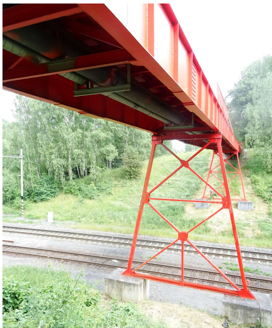
Obrázek 3: Pohled na betonové patky + vnitřní podpěru 02 (od opěry 01 - ul. Dyleňská)
