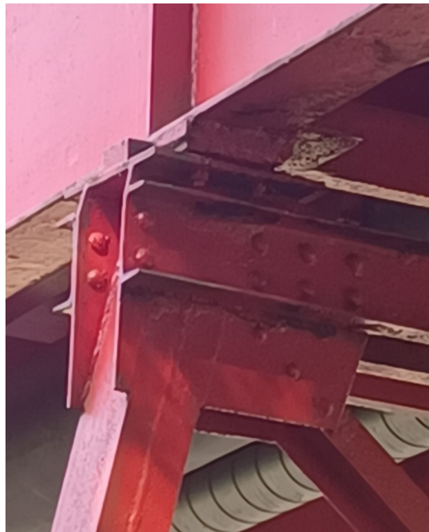
Obrázek 7 – Detail uložení NK na vnitřní podpěře
