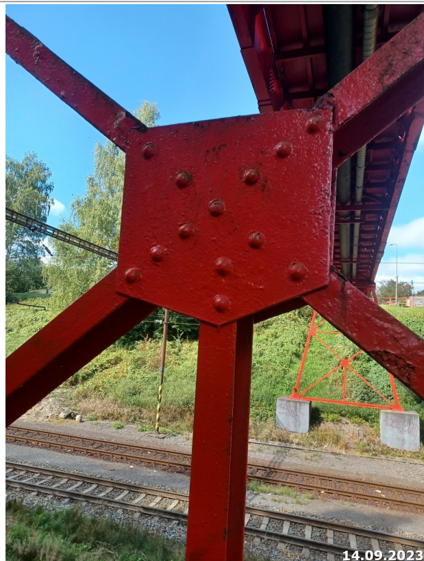
Obrázek 5 – Detail nýťového spoje vnitřní podpěry
