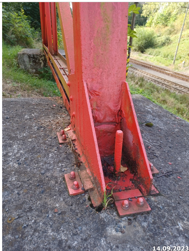
Obrázek 4: Detail kotvení podpěry k bet. patce
